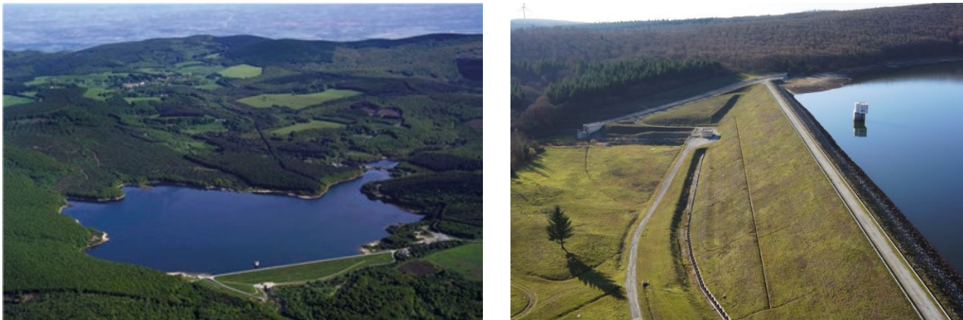
Vue aérienne du barrage de Laprade, de la digue de retenue et sa tour de prise d'eau
