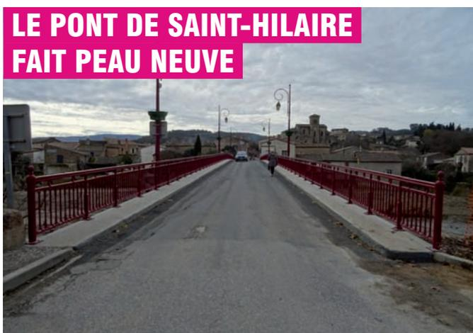
► Endommagé par les inondations d'octobre 2018, le pont qui enjambe le Lauquet sur la RD 104 à Saint-Hilaire a fait l'objet d'importants travaux de rénovation pour un coût de 390 000 €. Outre le renforcement des piles du pont, abîmées par les embâcles, des enrochements ont été apposés sur la rive droite de l'édifice pour le consolider. Les maçonneries, trottoirs et garde-corps ont également été rénovés.
