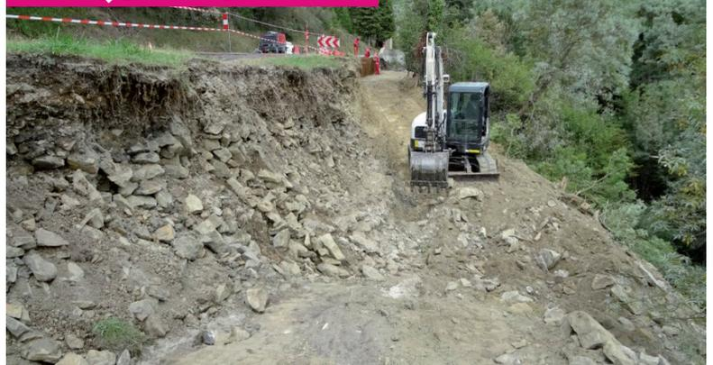
► La RD 42 s'offre une nouvelle jeunesse à Arquettes-en-Val avec la réfection de la chaussée, la mise en place d'une paroi clouée et la construction d'un parapet sur une portion endommagée lors des inondations d'octobre 2018. Les travaux qui ont commencé en septembre dernier doivent s'achever début 2020. Coût total du chantier : 625 000 €.
