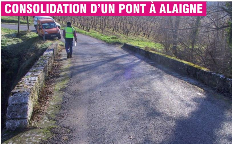
► Les travaux de renforcement du pont enjambant le ruisseau de Brugairolles, à la sortie d'Alaigne sur la RD 52, ont débuté en novembre pour s'achever début 2020. Différents travaux de maçonnerie vont permettre de consolider l'ouvrage avant la pose d'un garde-corps sur sa partie supérieure. Montant du chantier : 70 000 €.
