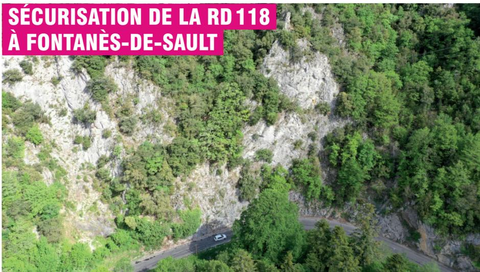
► Les travaux ont débuté fin septembre dans la Haute-Vallée pour sécuriser la chaussée de la RD 118 à Fontanès-de-Sault, menacée par des éboulis de roches. Afin d'y remédier, des travaux de minage sont effectués dans les parois rocheuses pour éliminer les parties instables et des écrans pare-blocs sont installés pour empêcher la chute de pierres sur la chaussée. Coût des travaux : 190 000 €.
