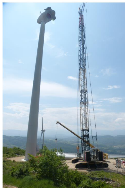
Montage d'une éolienne - parc de Bourière
