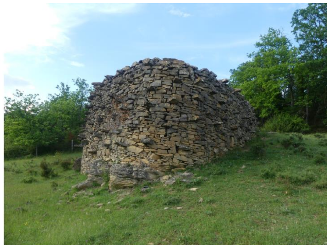
Etrange construction de pierres («Peyregas») - Bourigeole
