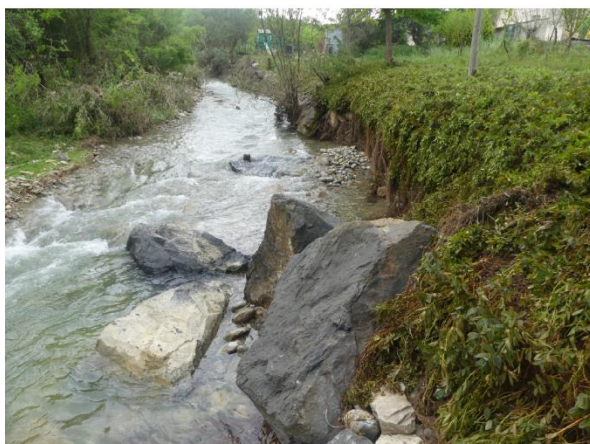
Déplacement des enrochements sur la Corneilla
