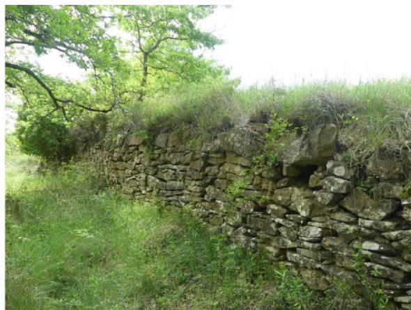
Muret de soutènement en bon état de conservation à la Métairie d'Encoste (Bourigeole)
