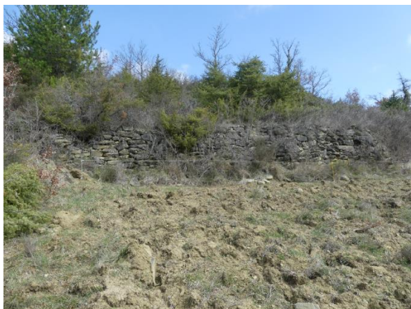
Muret de soutènement en bon état de conservation à «al Bessou» (Festes-et-Saint-André)
