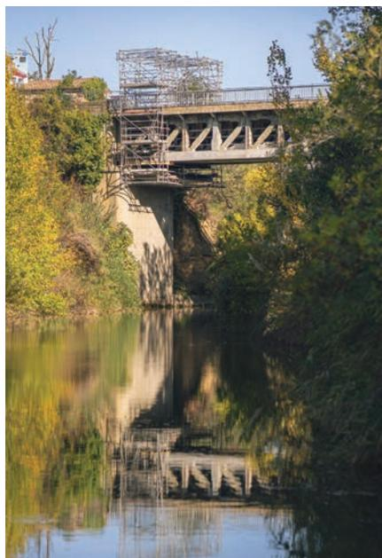
La fragilisation du pont, durant les travaux, ainsi que les contraintes environnementales liées à ce chantier, au-dessus de la Nielle, ont amené à faire le choix d'un système d'échafaudage en deux parties (plus léger qu'un seul installé sur tout l'ouvrage). Deux équipes d'ouvriers de la SARL AGTP interviennent avec un planning différent pour optimiser les tâches.
