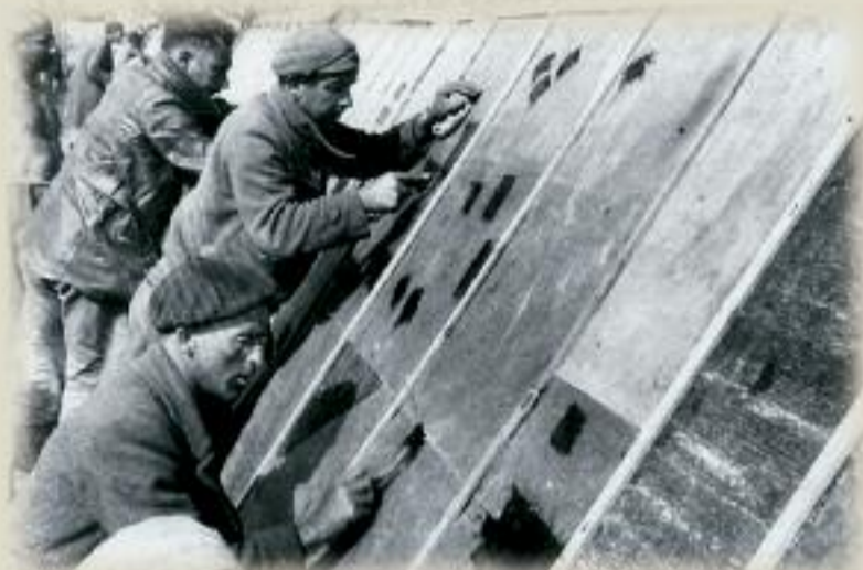
Réparation de la couverture d'une baraque, 1939, photographie Agustí Centelles, © Adagp, Paris 2004.
