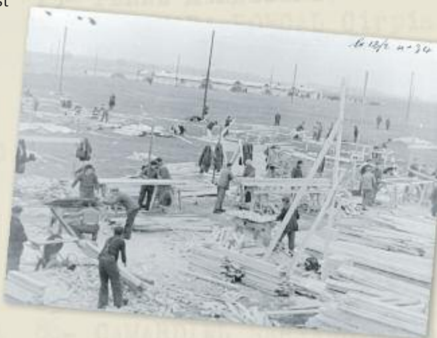
Construction des baraquements, 12 février 1939, photographie Rougé, Carcassonne.
