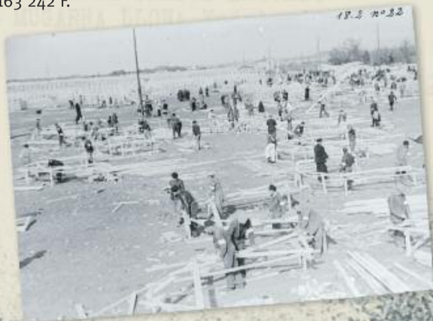
Construction des baraquements, 18 février 1939, photographie Rougé, Carcassonne.
