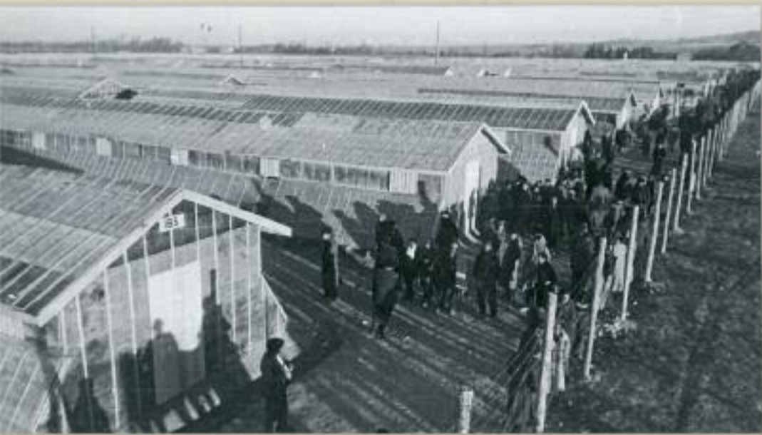
Les réfugiés devant les baraques, une fois finie la construction, 1939, photographie Rougé, Carcassonne.
