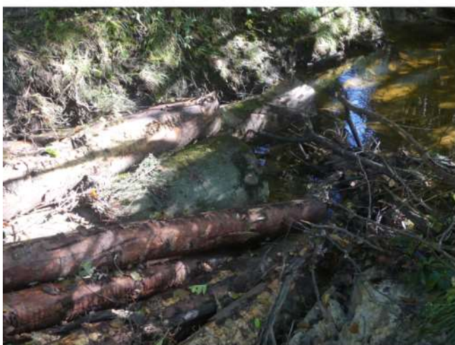
Buse sur la branche sud du ruisseau de la Tourbière du Pinet et lit encombré de grumes
