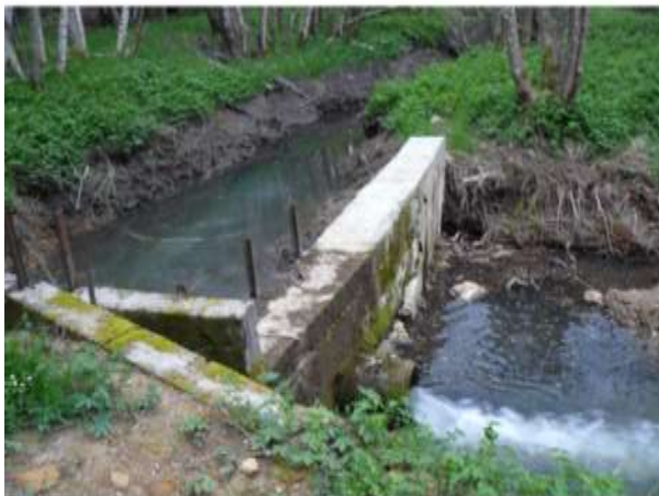
Ouvrage compromettant la continuité hydraulique du Rébounédou (aval de Font Blanche)
