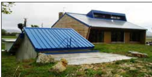
Trappe du silo
